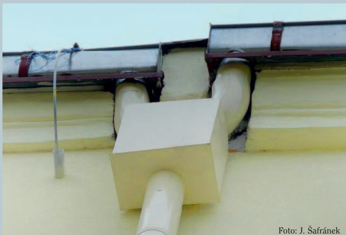
Okapový svod s plechovým kotlíkem.
