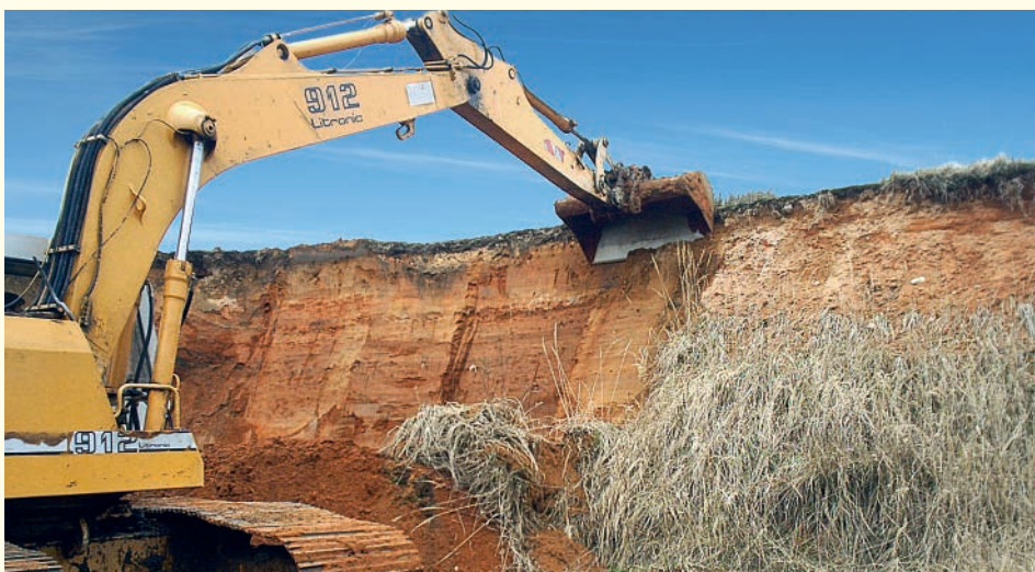
Obnova hnízdní stěny v pískovně Lžín za pomoci bagru.
