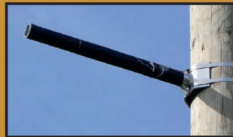
Dosedací tyč (bidlo) má průměr 6 cm, doporučená délka je 120 cm.
