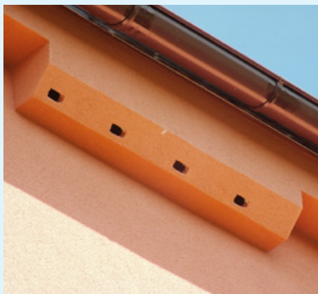
Polystyrenové budky zakomponované do fasády mohou představovat zajímavý estetický prvek na budově.
