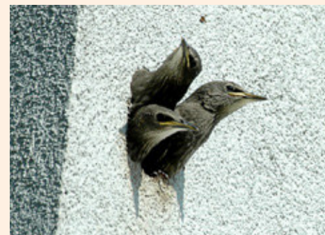
Špačci jsou velmi častými nájemníky strakapoudích dutin v zateplení
