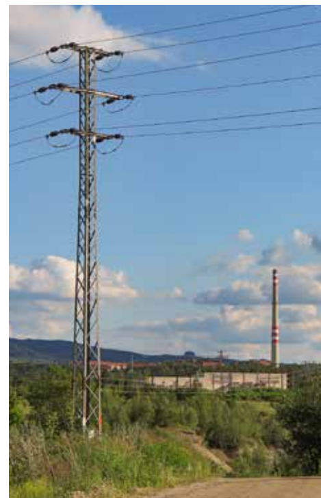
Pohled z místa nálezu spáleného samečka směrem na komín chemičky v Sokolově, na kterém je umístěna budka
