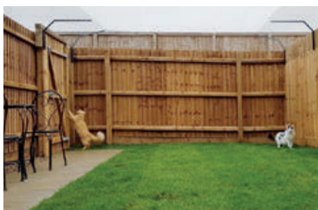
Na plotové sloupky namontujeme nástavce (tzv. bavolety) směrem dovnitř pozemku a na ně natáhneme pletivo
