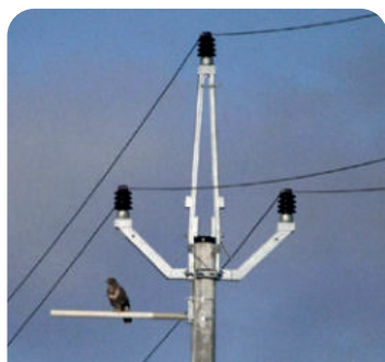
2011–2012 – Testování účinnosti bidel na konzolách typu „pařát“ v terénu; ve spolupráci s AOPK jsme ověřili, že výrazně snižují úhyn ptáků
